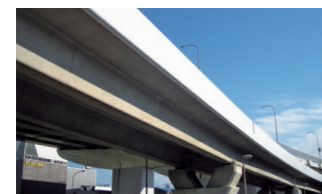
ウレアウレタン樹脂が施工された高速道路の橋梁 Expressway bridge coated with urea urethane resin
