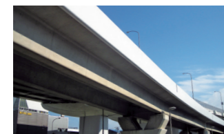
ウレアウレタン樹脂が施工された高速道路の橋梁 Expressway bridge coated with urea urethane resin
